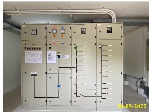
Main Distribution Board อาคาร B
